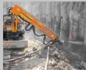
Der Spritzmanipulator AL-302 aufgebaut auf einem Kleinbagger ist die ideale Kombination um mit der AL-267 eine grosse Leistung, bis zu 21 m<sup>3</sup> pro Stunde, zu fördern. Baugruben- und Felssicherungen sowie andere Anwendungen können damit effizient und ökonomisch ausgeführt werden.
