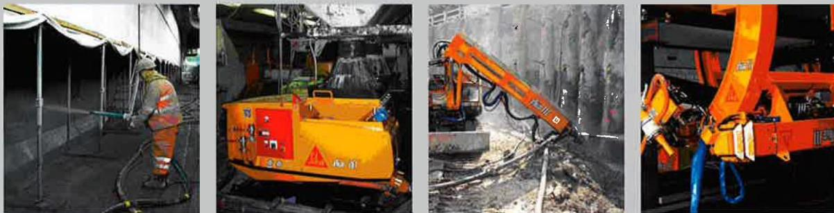
Betonsanierungen mit Spritzbeton im Trockenspritzverfahren garantieren eine gute Haftung bei der Kieshinterfüllung von des Materials und eine ausgezeichnete Verdichtung. Je nach Anforderung kann die AL-237, AL-257 oder die AL-267 eingesetzt werden.
