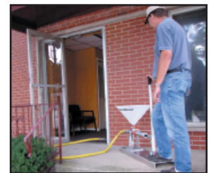
Filling Door Frame
